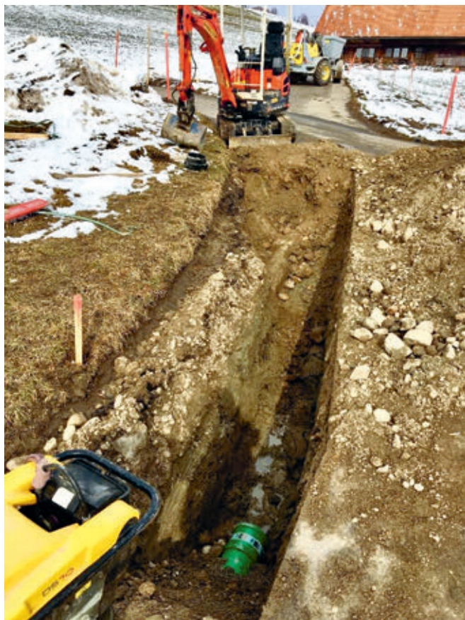
Graben für Ersatz der bestehenden Leitung
