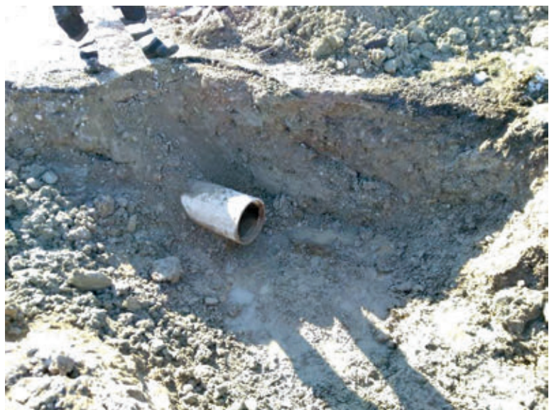
Bestehendes Rohr in gutem Zustand
