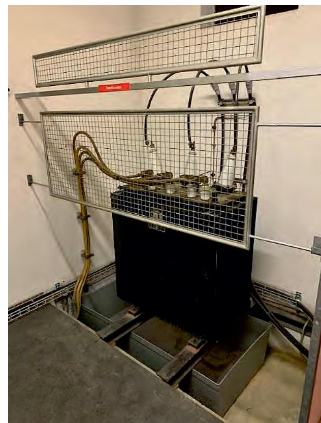
Der Transformer in der Trafostation Lochmatt versorgt das Gebiet Arnistrasse (ab Nr. 22), Aueliweg (ab Nr. 27) und die Lochmatt. Neben den Haushaltungen versorgt er auch das Pumpwerk Lochmatt für die Wasserförderung ins Reservoir Berg und nimmt die Energie der PV Anlage Lochmatt 104b ab. Er war mit Jahrgang 1940 der Älteste im Verteilgebiet der Energieversorgung Biglen. Die Verlustleistung war enorm hoch und die Betriebssicherheit konnte nicht mehr gewährleistet werden.
