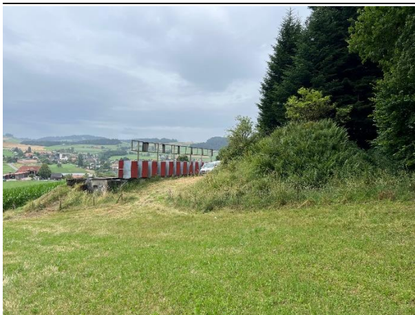
Foto Nr. 3: Kugelfanganlage mit Blickrichtung SO.
