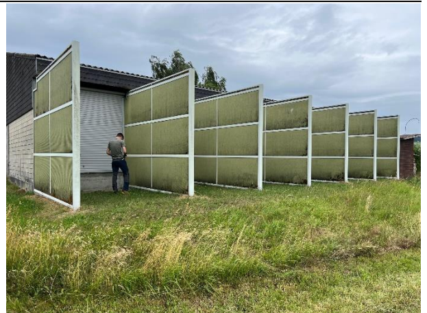
Foto Nr. 2: Schützenhaus.
