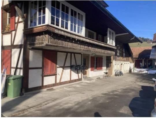
Abbildung 10: Gefährdete Bauteile / Fassadenöffnungen in der gelben Zone entlang der östliche Fassade der Liegenschaft Rohrstrasse 17. Empfohlene Schutzmassnahme: Einbau wasserdichte Türe. HQ300 Abflusstiefe < 0.5m.
