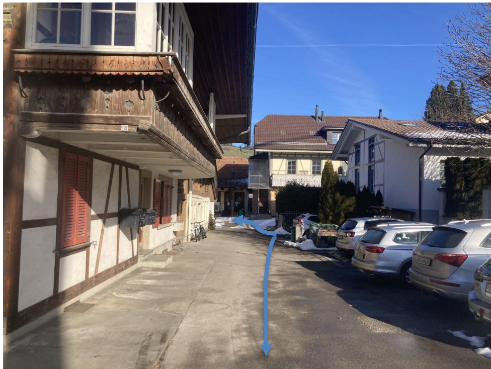
Abbildung 6: Gebiet mit Hochwassergefährdung entlang der Ostfassade der Liegenschaft Rohrstrasse 17 (Blick nach Norden. Fliessrichtungen des Hochwassers mit blauen Pfeilen eingezeichnet.).
