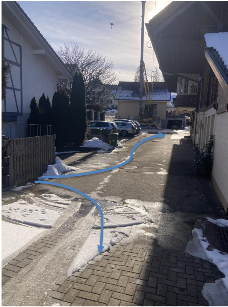
Abbildung 8: Eindolung des Biglenbachs unter Parzelle 803 ("Eindolung Restaurant Sonne / Gärbi"), Gebiet der Hochwassergefährdung entlang der Ostfassade der Liegenschaft Rohrstrasse 17 (Blick nach Süden. Fliessrichtungen des Hochwassers mit blauen Pfeilen eingezeichnet.).
