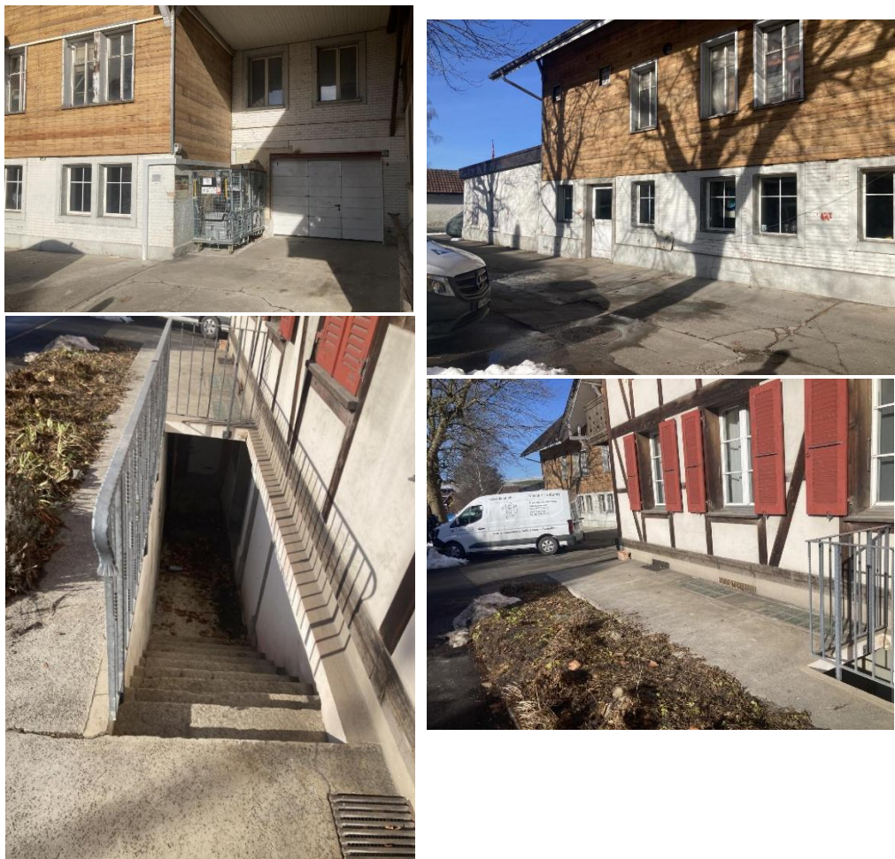
Abbildung 9: Gefährdeten Bauteile / Gebäudeöffnungen in der gelben Zone entlang der südliche Fassade der Liegenschaften Rohrstrasse 15 und 17. Wasserdichte Türen (oben links und rechts) sind erforderlich. Zum Schutz des Kellerzugangs werden mobile Massnahmen (Bereitstellung von Sandsäcken oder Schalungstafeln) sowie ein Notfallkonzept empfohlen. HQ300 Abflusstiefe < 0.5m.
