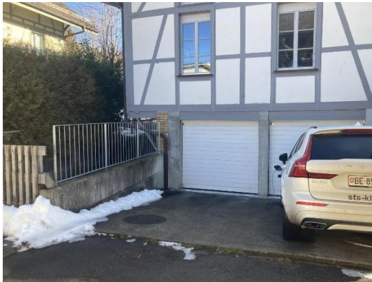
Abbildung 10: Gefährdete Bauteile / Fassadenöffnungen in der gelben Zone entlang der östliche Fassade der Liegenschaft Rohrstrasse 17. Empfohlene Schutzmassnahme: Einbau wasserdichte Türe. HQ300 Abflusstiefe < 0.5m.
