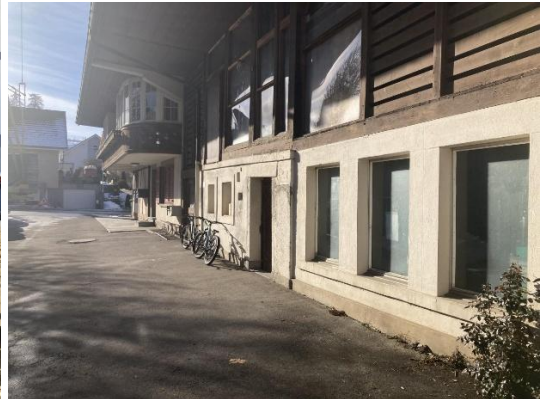
Abbildung 10: Gefährdete Bauteile / Fassadenöffnungen in der gelben Zone entlang der östliche Fassade der Liegenschaft Rohrstrasse 17. Empfohlene Schutzmassnahme: Einbau wasserdichte Türe. HQ300 Abflusstiefe < 0.5m.
