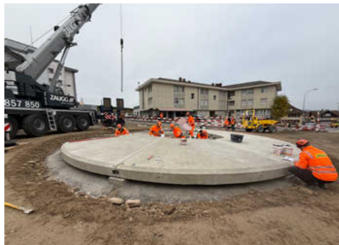
Intensivbauphase beim Kreisel Bahnhofstrasse Anfang Oktober 2025: Einbau der Betonelemente in der Kreiselmitte (Bild: Gruner AG)
