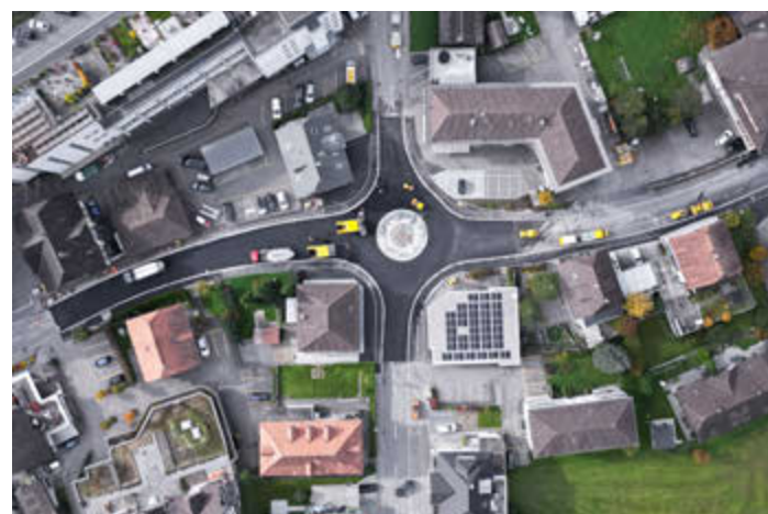
Bild aus der Vogelperspektive während den finalen Belagsarbeiten (Drohnenaufnahme: dropzone.ch)
