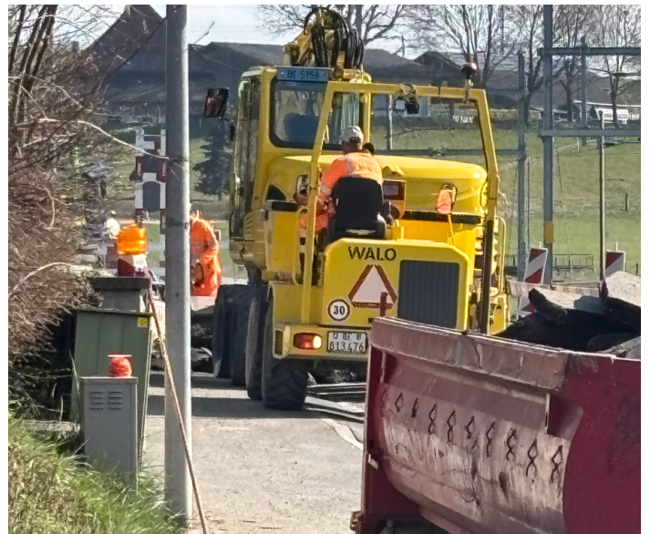
Blick von Syrengasse zur Rothackerstrasse
